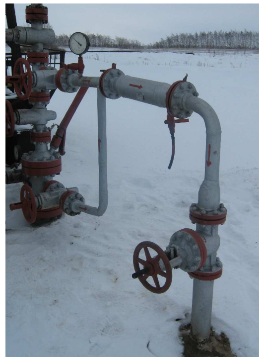
Установка пробоотборника ППЖР-01 (горизонтальное размещение) с фланцевым соединением на скважине №40 Тверского месторождения ОАО «Самаранефтегаз»
